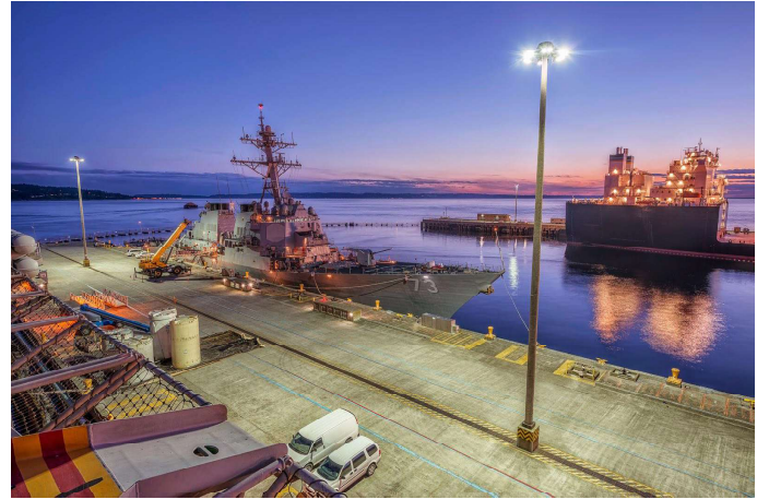
Éclairage de port
